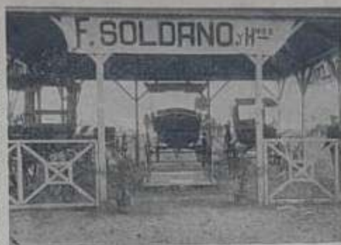
Vista una parte interior
