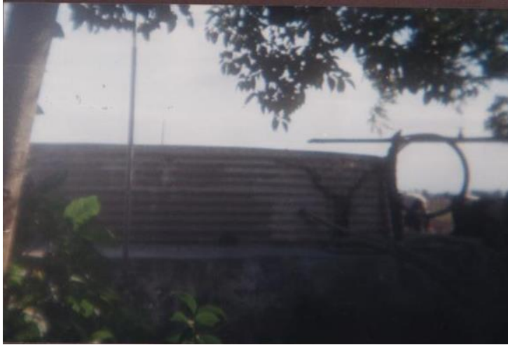
Tanque de agua con caño aéreo que viene del molino
