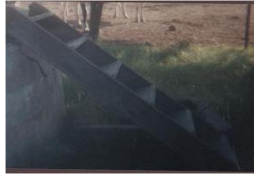
Escalera al tanque, que originalmente perteneciera al sótano
