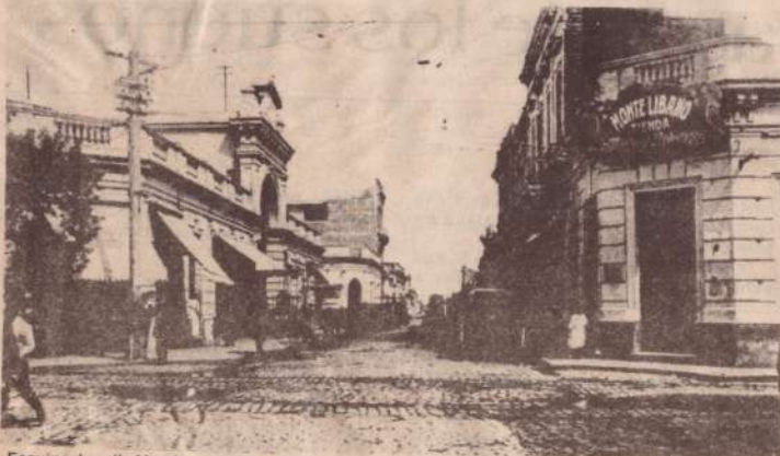
Esquina de calle Mendoza y San Jerónimo, con adoquinado de piedras
