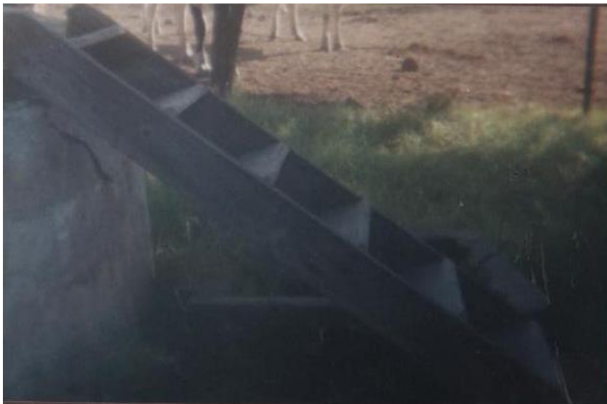
Escalera original que conducía al sotán
