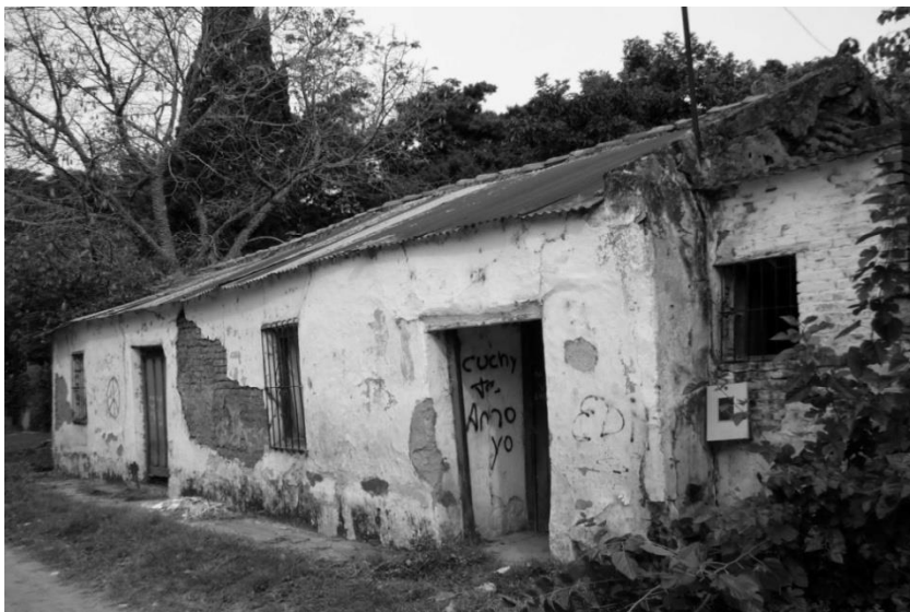
Construcción colonial en pie de adobe y paja, con aberturas y herrajes originales.
